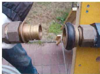
蛇口盤配管入口への接続
