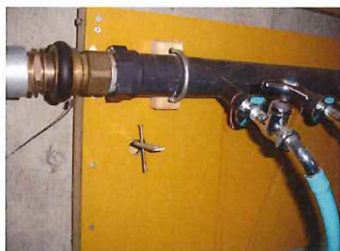
蛇口盤の取り出しはピンを抜いてから
