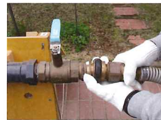
出口を次のホースに接続 止水バルブは閉のまま
