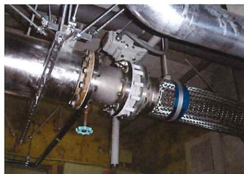
緊急遮断弁の制御盤はポンプ室入口付近に設置されており、内蔵バッテリーにより停電時も作動します。緊急遮断弁が作動すると、緑色のパイロットランプが、その下の赤いパイロットランプに切り替わります。
